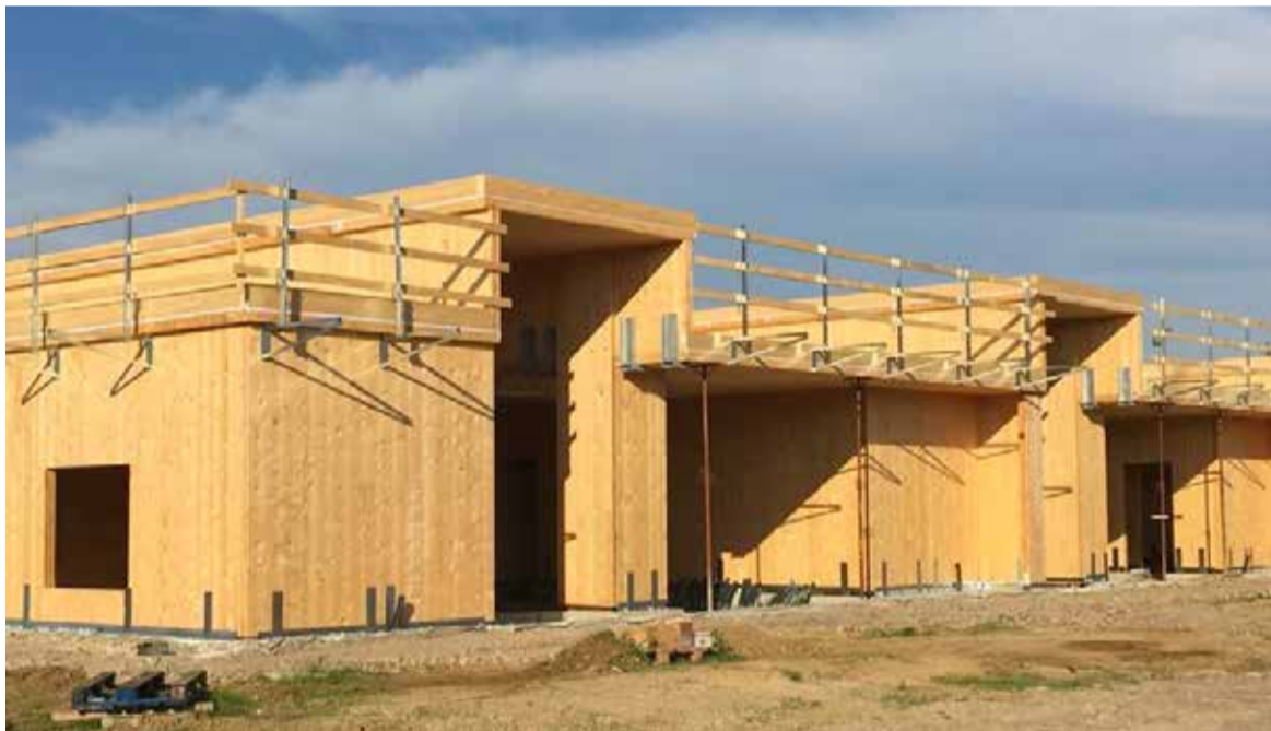
Il cantiere della scuola dell'infanzia di Canonica
